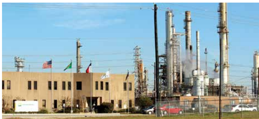
Nhà máy Lọc dầu Pasadena. Nguồn: Houston Public Media
