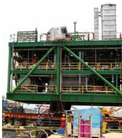
Tổ hợp Module train A được hạ thủy xuống sà lan VSP-05 để vận chuyển và lắp đặt trên biển. Ảnh: Tiến Xuân
